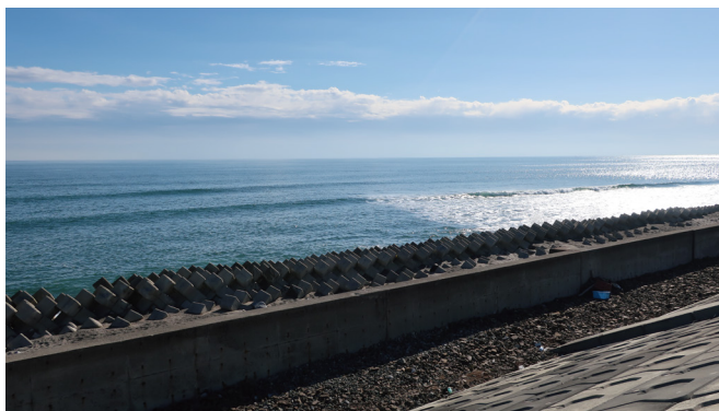
▲現在の井土地区の海岸にはテトラポットが並んでいます
